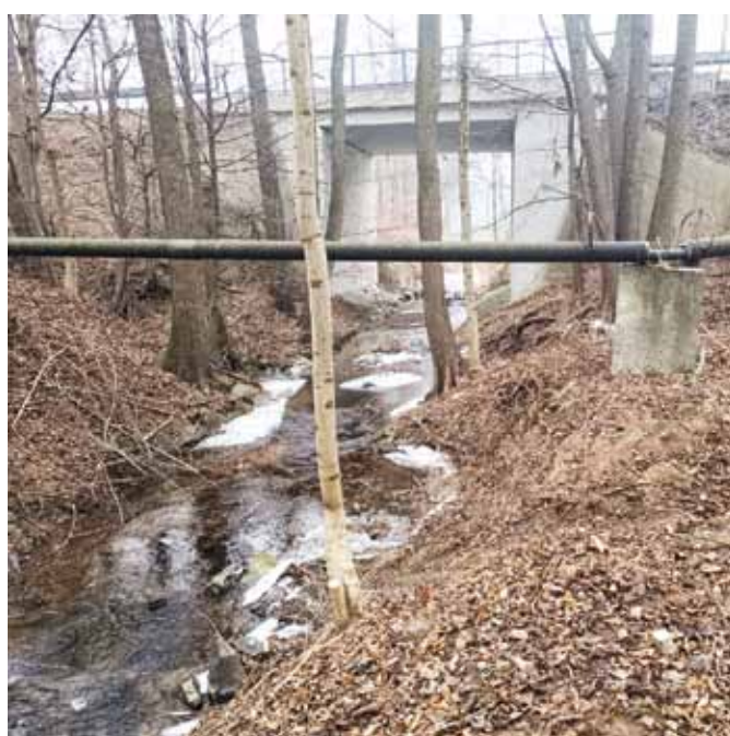
Stav po vyčištění a ukončené prořezávce
