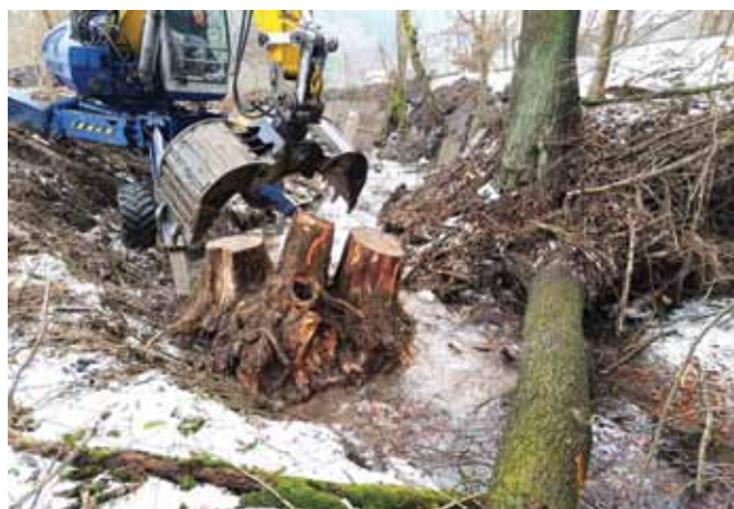
Průběh prací a uložení panelů do původního stavu
