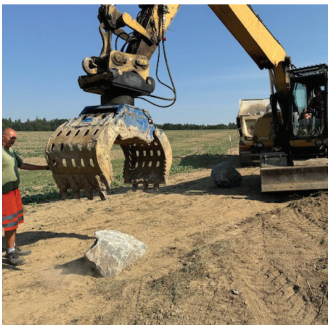
Ukládání kamenů na vytyčenou stezku
