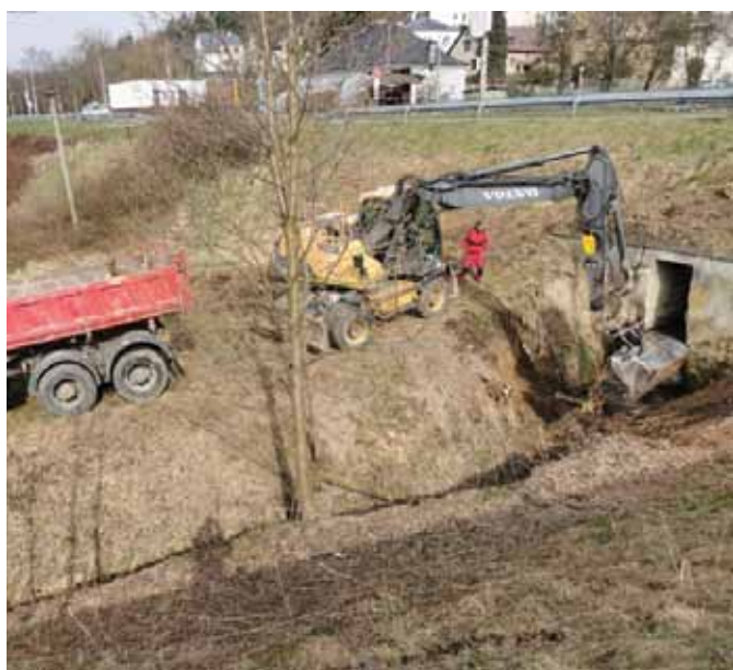
Průběh prací při čištění vyústění odpadních vod na nádraží
