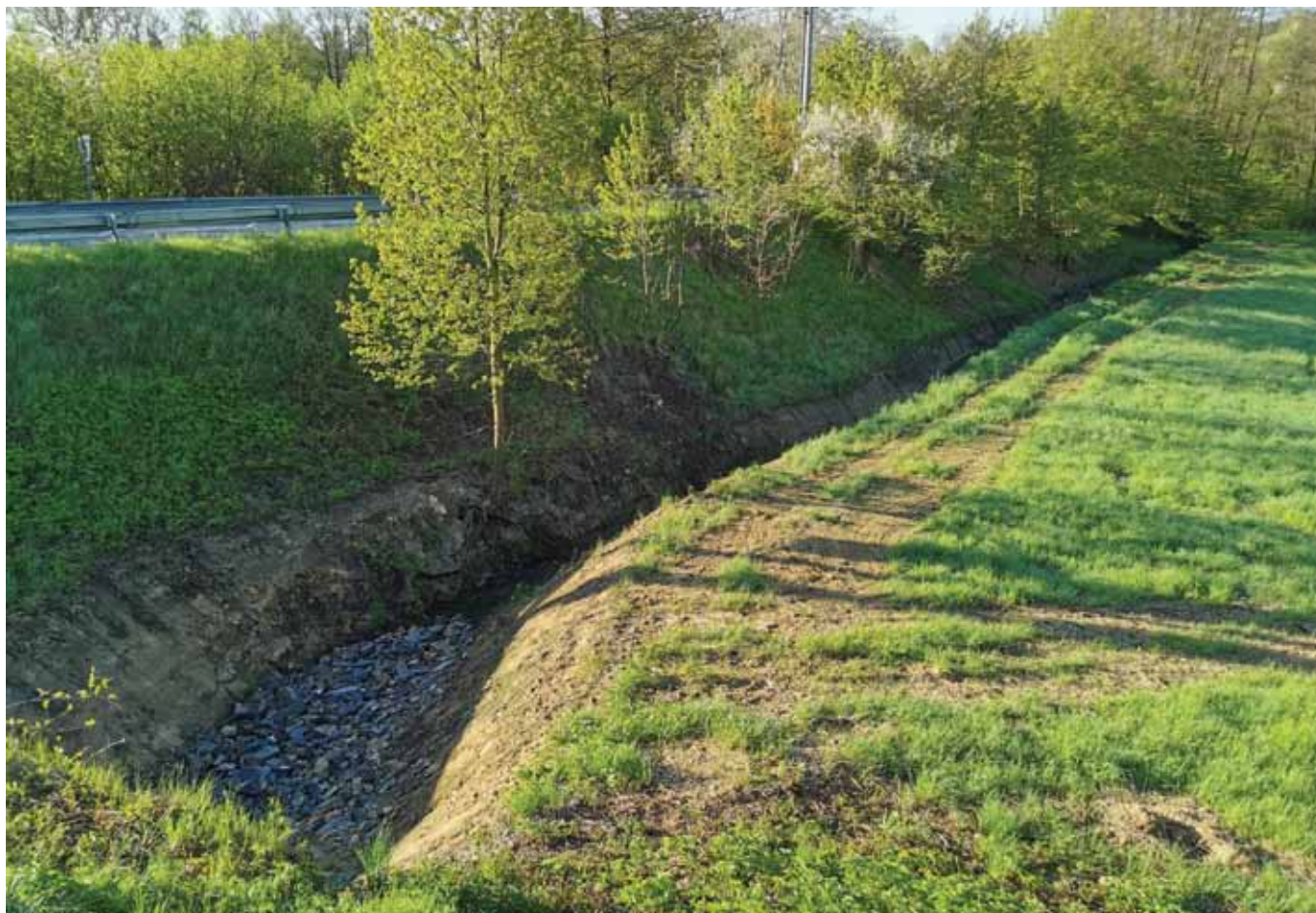
Nový stav po vyčištění vyústění odpadních vod na nádraží
