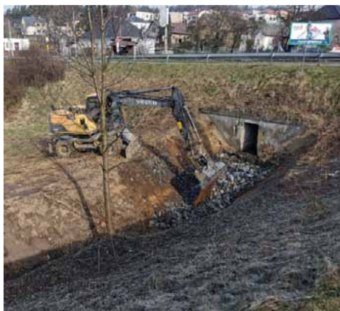
Průběh prací při čištění vyústění odpadních vod na nádraží
