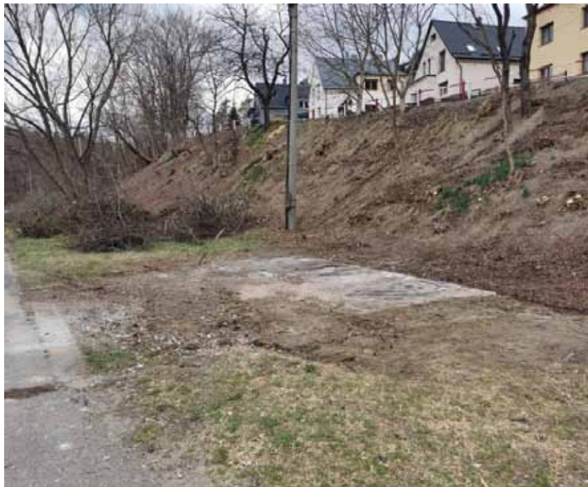
Nový stav po demolici staré stavby – váhy, na nádraží
