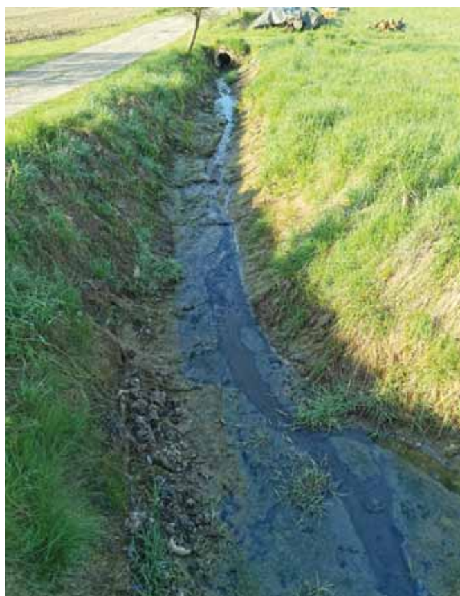
Po vyčištění vyústění odpadních vod Pod Budkovcem
